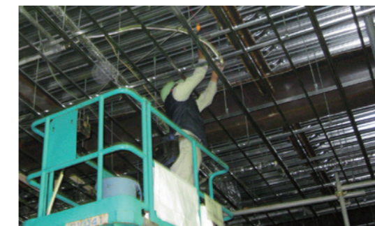
スプリンクラー設備・工事では、当社グループの協業が最大の強み
