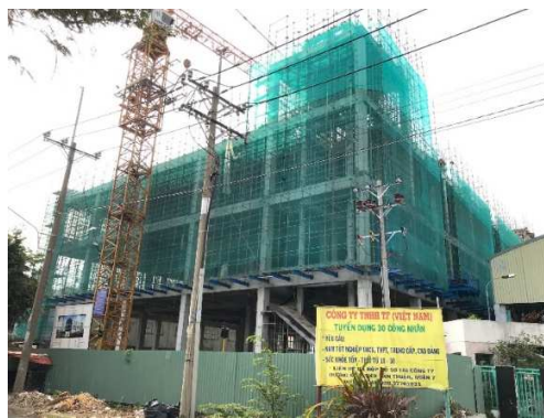
増床工事中のベトナム工場 TF(VIETNAM)CO.,LTD.・ベトナム国ホーチミン市
