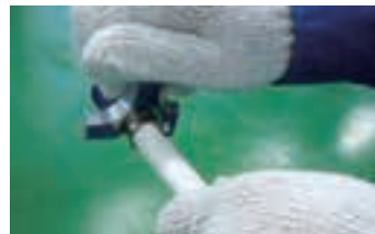
③カシメ確認ゲージをプレス痕の溝に挿入
