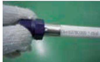
①挿入確認窓からパイプが見えることを確認
