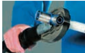
①挿入確認窓からパイプが見えることを確認
