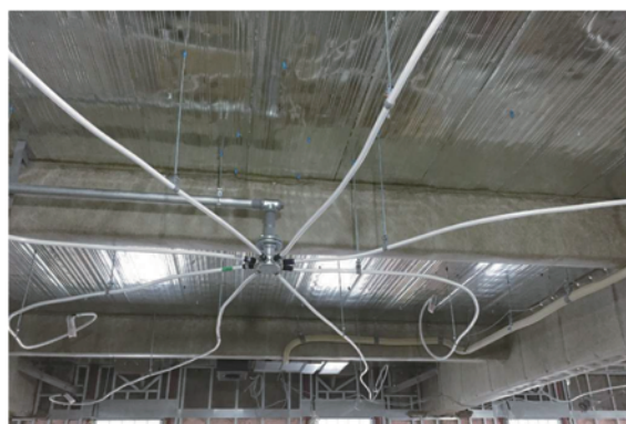
(例 3) 25A 枝管の代替として施工
