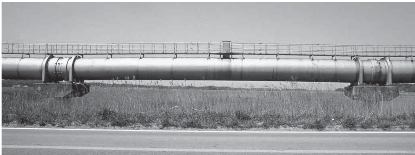
水管橋 伸縮管 (SA型)
