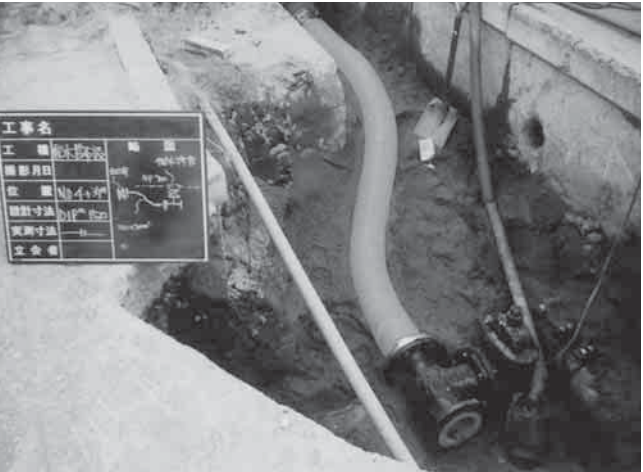
芯ずれの施工例
