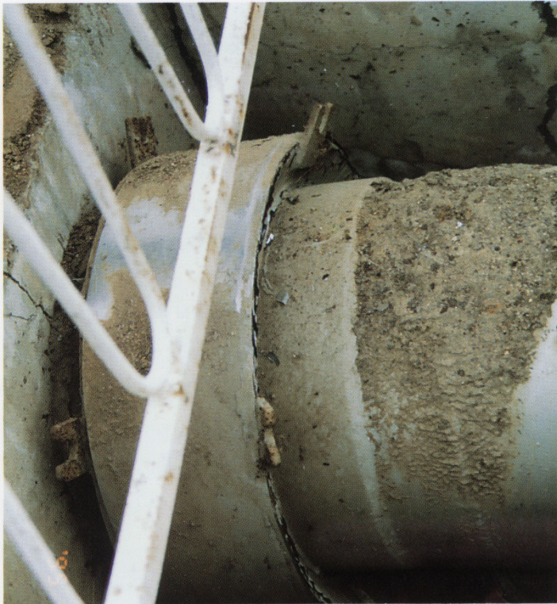
●妙法寺川水管橋 許容量25mm実際の動き75mm
