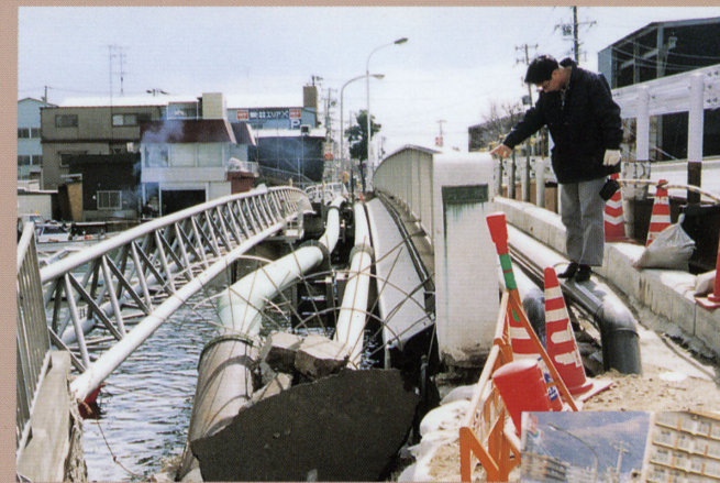
●苅藻橋護岸が崩れ、水道管も大きく曲がった
