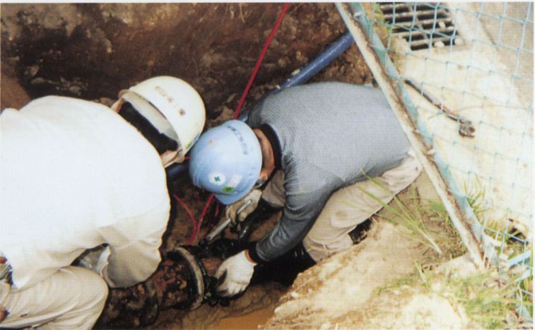
●漏洩した水道管の修理作業
