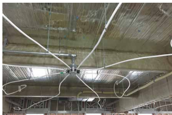
25A 枝管の代替として施工
